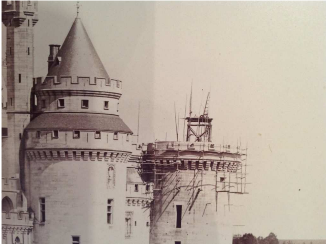
Chantier du château de Pierrefonds, XIX e siècle, chèvre et sa grue à bras métallique implantées sur la tour Charlemagne
